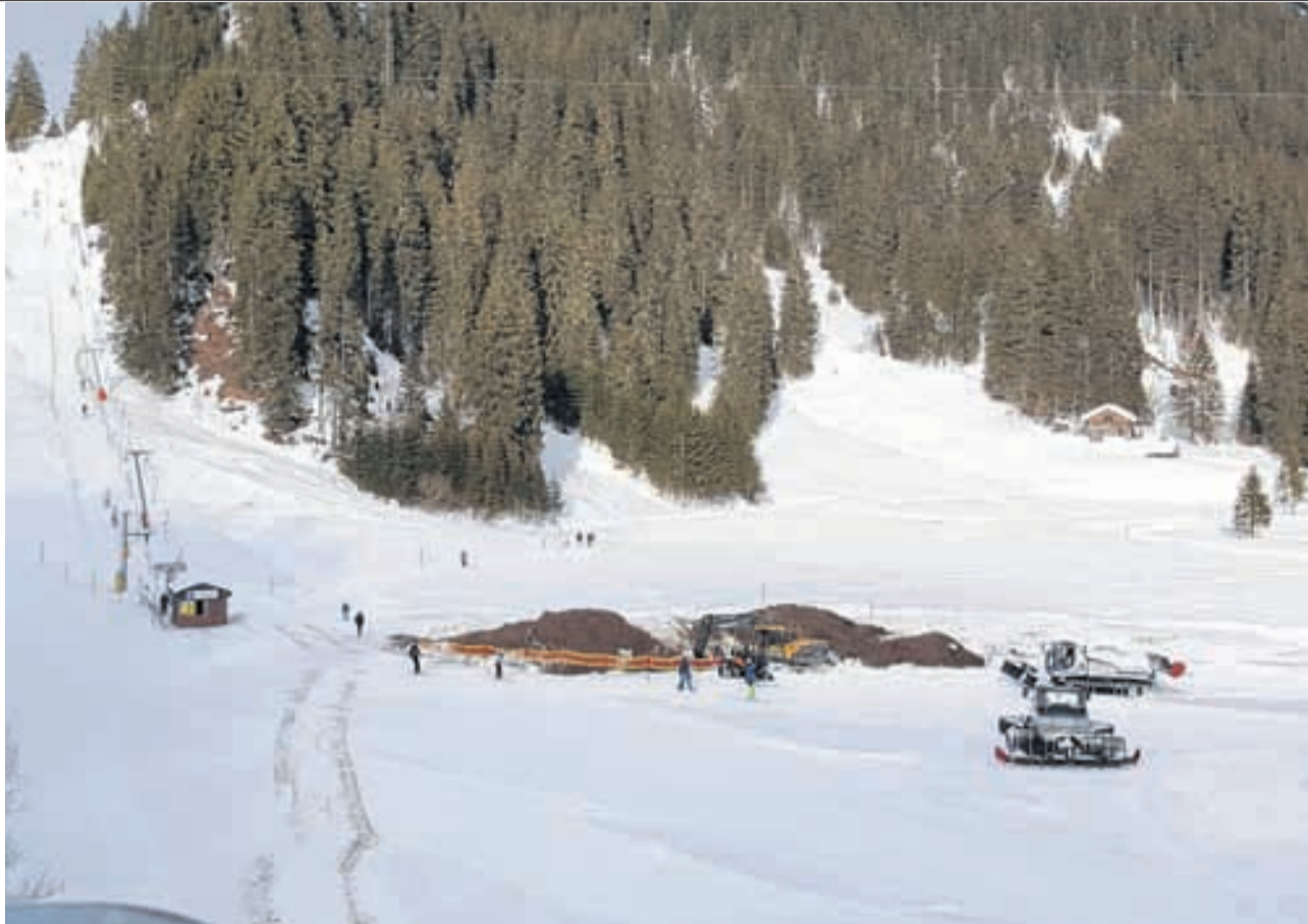
Am Dienstag baggerte man in der Nähe des Seeblistees nach der Ursache für den Wasserrohrbruch.
